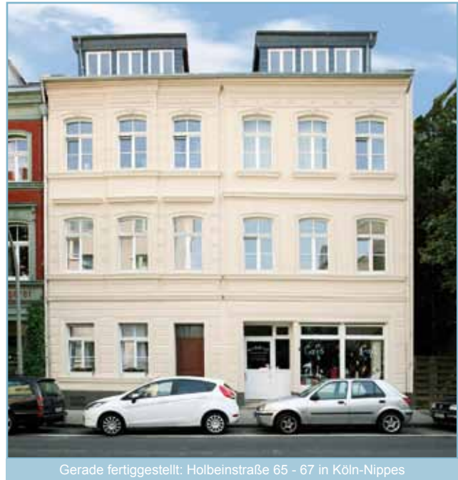
Gerade fertiggestellt: Holbeinstraße 65 - 67 in Köln-Nippes
