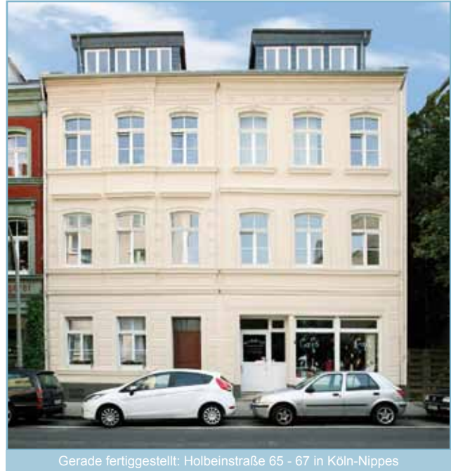
Gerade fertiggestellt: Holbeinstraße 65 - 67 in Köln-Nippes
